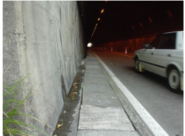
写真-1 未対策の井の岬トンネル
